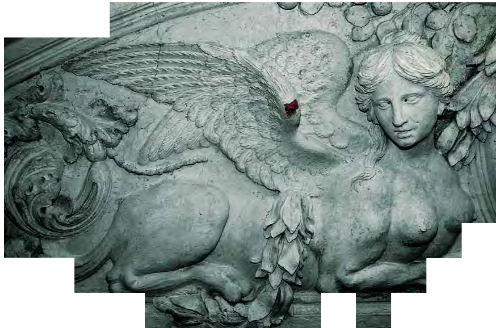
Fragment dekoracji sztukatorskiej po usunięciu wtórnych nawarstwień
