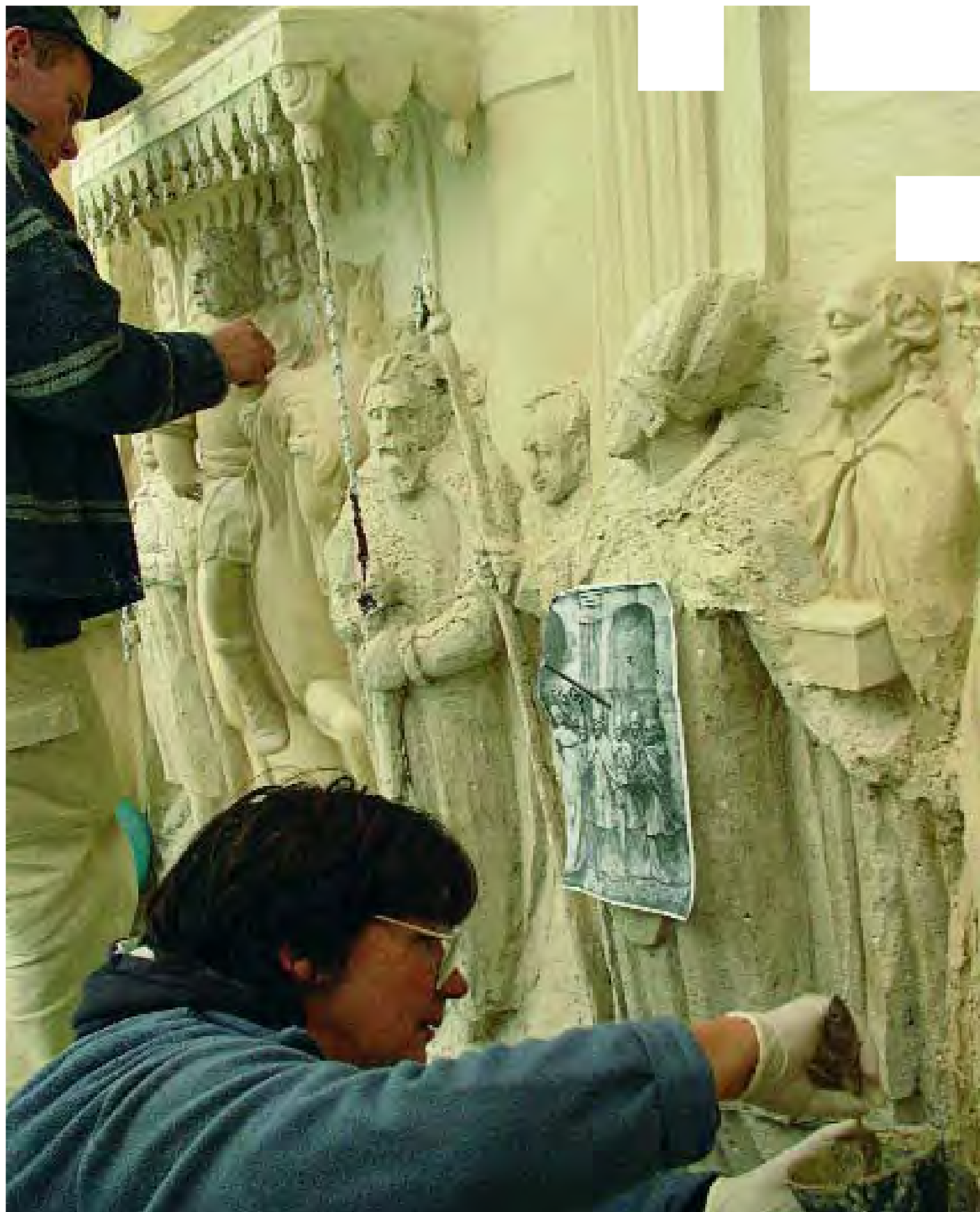
Uzupełnianie ubytków zniszczonej powierzchni płaskorzeźb
