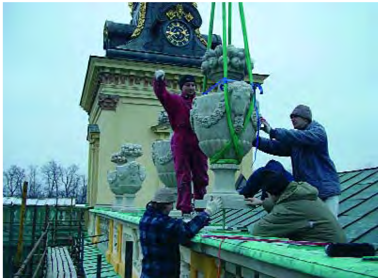
Montaż dekoracji rzeźbiarskich na attyce pałacowej po wykonaniu obróbek blacharskich
