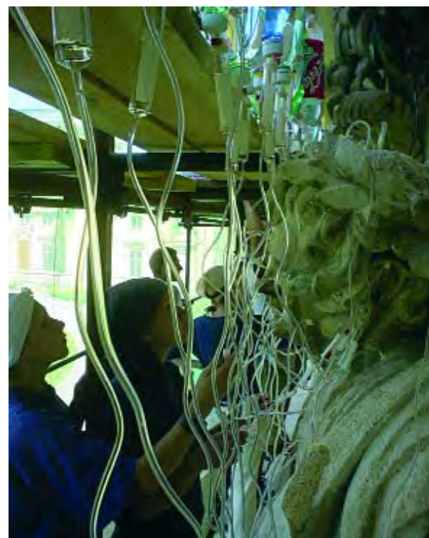
Impregnacja elementów wystroju rzeźbiarskiego elewacji
