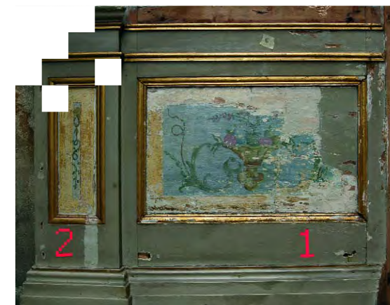
Boazeria, usuwanie przemalowań
