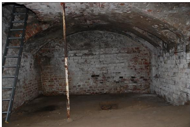
Fot. 15 Widok ceglanego sklepienia kolebkowego nad piwnicą wschodnią.
