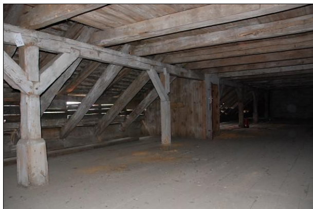
Fot. 25 Widok więźby dachowej w 1 poziomie poddasza.
