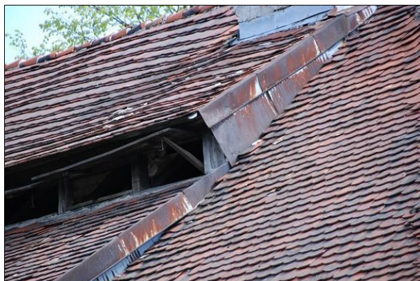
Fot. 27 Widok pokrycia i obróbkę blacharskich przy świetliku dachowym.
