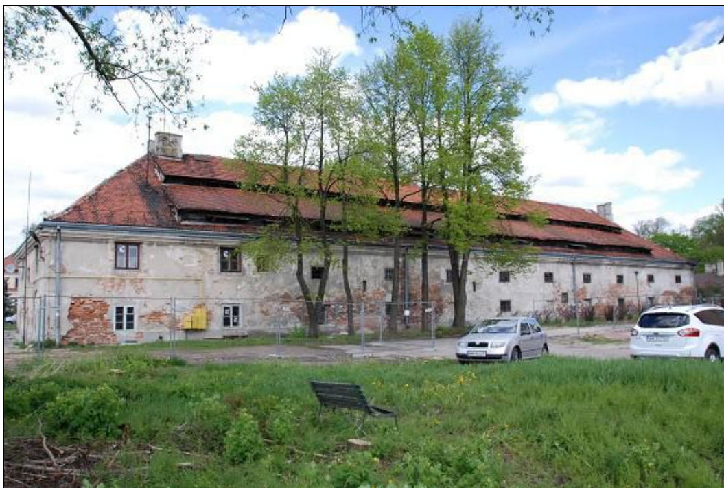
Fot. 1 Widok elewacji południowej budynku.
