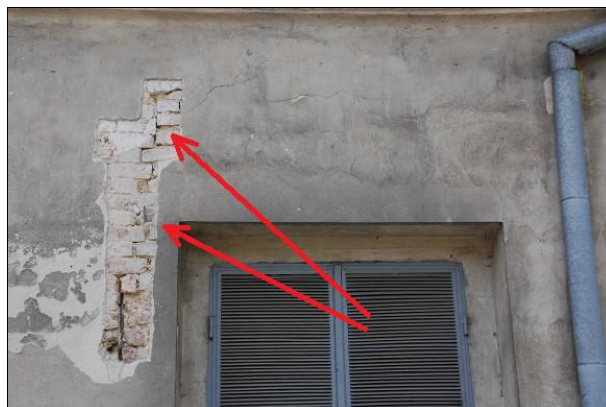
Fot. 36 Widok wtórnego otworu do stacji trafo. Widoczna stalowa belka z C120 oraz spękanie muru.
