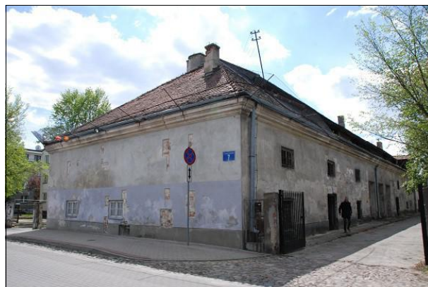
Fot. 3 Widok elewacji północno – wschodniej.
