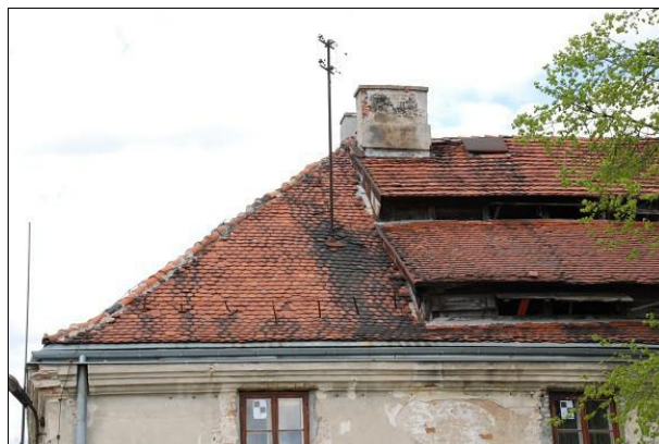
Fot. 28 Widok pokrycia dachu.
