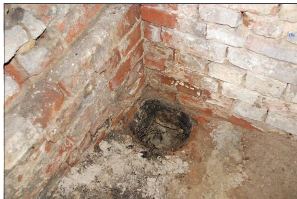
Fot. 5 Widok odkrywki nr 2.
