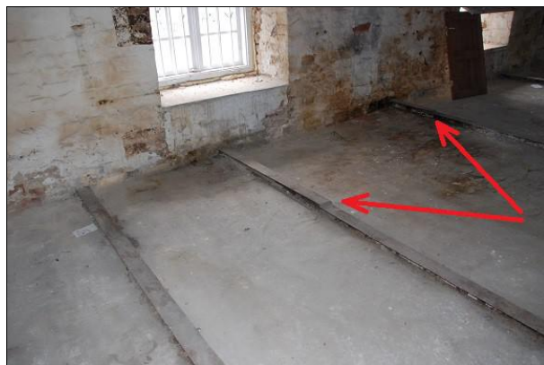
Fot. 44 Widoczne połączenia belek stalowych.
