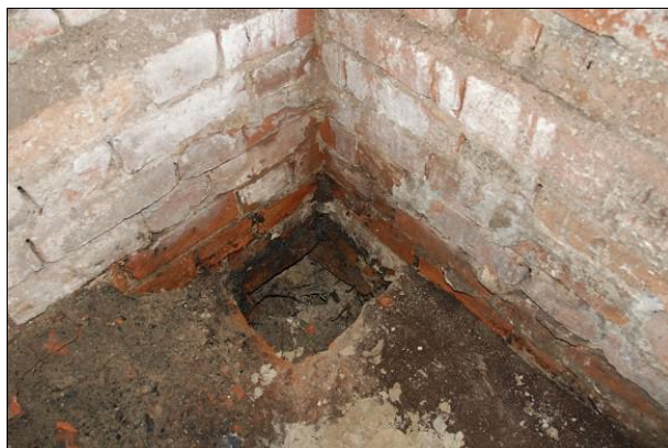
Fot. 4 Widok odkrywki nr 1.
