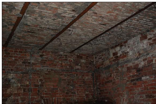
Fot. 16 Widok stropu Kleina nad piwnicą wschodnią.
