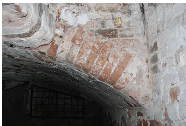
Fot. 46 Widoczna grubość sklepienia nad piwnicą wschodnią.
