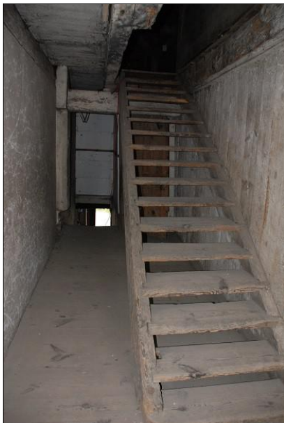
Fot. 29 Widok schodów na 1 poddasze.
