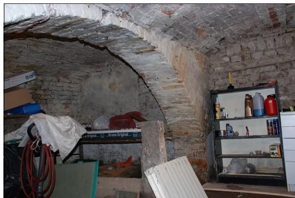
Fot. 18 Widok ceglanego sklepienia nad piwnicą zachodnią.
