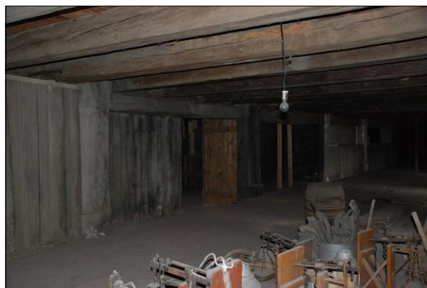
Fot. 24 Widok stropu belkowego nad 1 piętrem w części środkowej.
