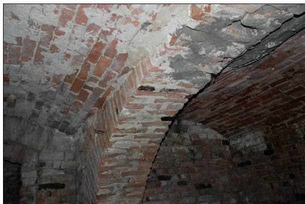
Fot. 17 Widok ceglanego sklepienia nad piwnicą zachodnią.
