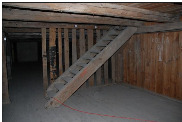
Fot. 30 Widok schodów na 2 poddasze.
