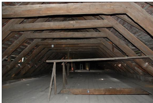
Fot. 26 Widok więźby dachowej w 2 poziomie poddasza.
