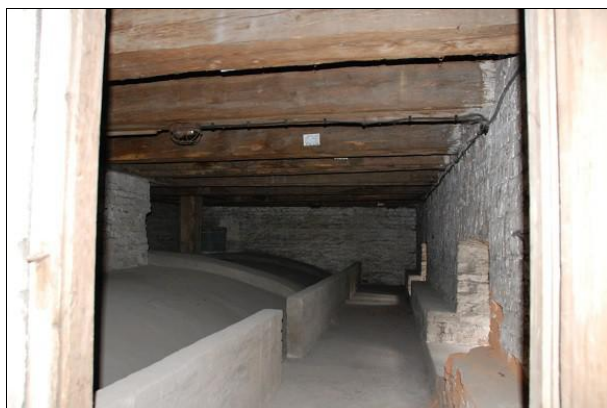
Fot. 23 Widok stropu belkowego nad 1 piętrem w części wschodniej.
