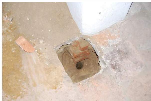
Fot. 7 Widok odkrywki nr 4.
