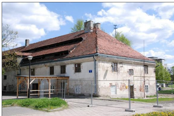
Fot. 2 Widok elewacji północno – zachodniej.
