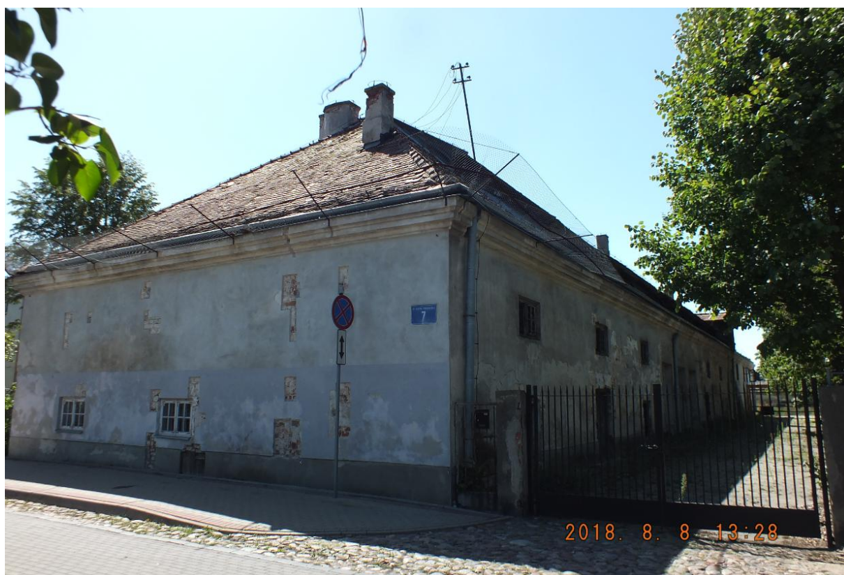
Fot. 6. Widok ogólny budynku dawnej słodowni od strony wschodniej
