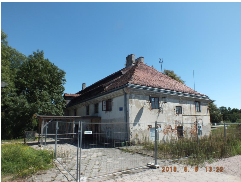
Fot. 2. Widok ogólny budynku słodowni wchodzącego w skład obiektów gospodarczych Pałacu w Wilanowie
