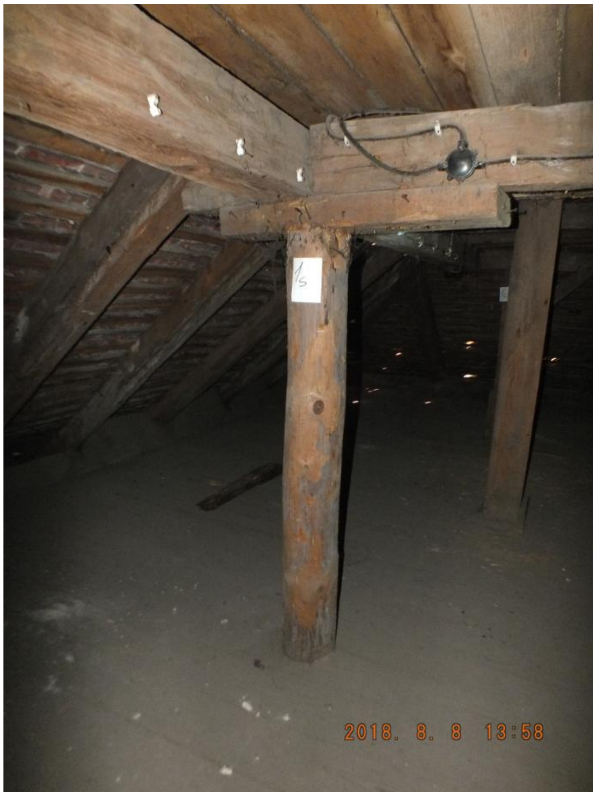
Fot. 16. Wtórne podparcie drewnianej płatwi
