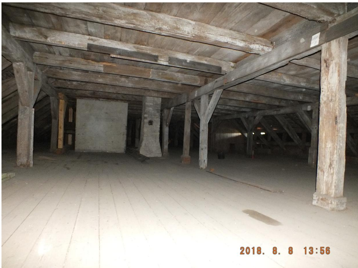
Fot. 13. Widok ogólny niższego poziomu więźby dachowej
