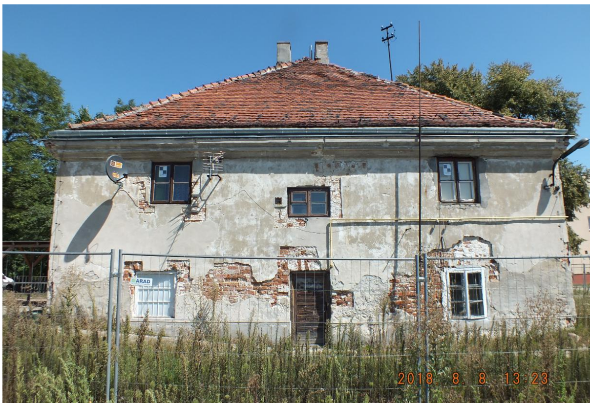
Fot. 9. Ilustracja elewacji zachodniej
