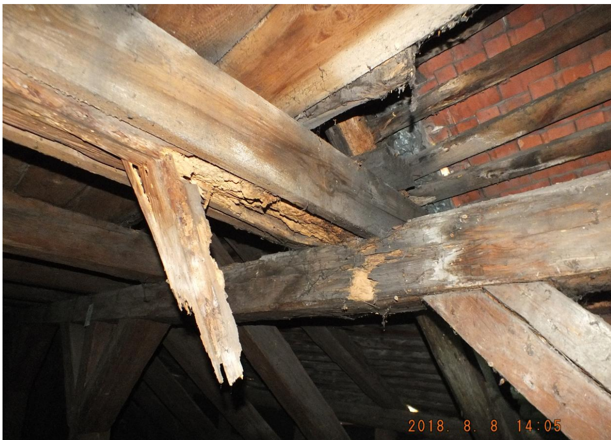
Fot. 18. Widok oparcia wtórnie wzmocnionej jętki na płatwi
