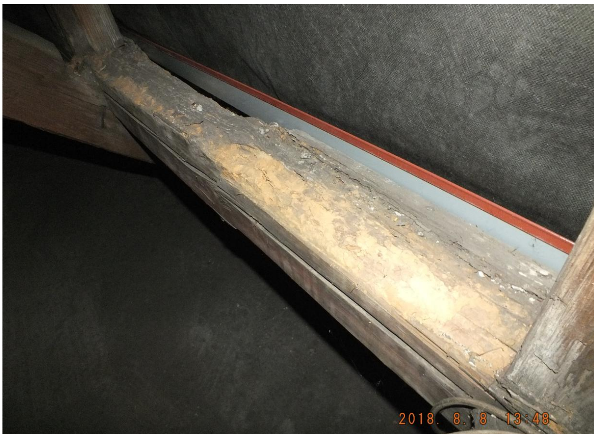
Fot. 21. Ilustracja porażen drewnojadami dolnej płatwi świetlika
