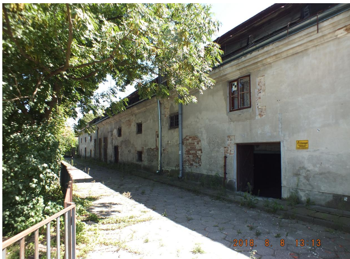
Fot. 7. Widok ogólny przedmiotowego budynku od północnej strony
