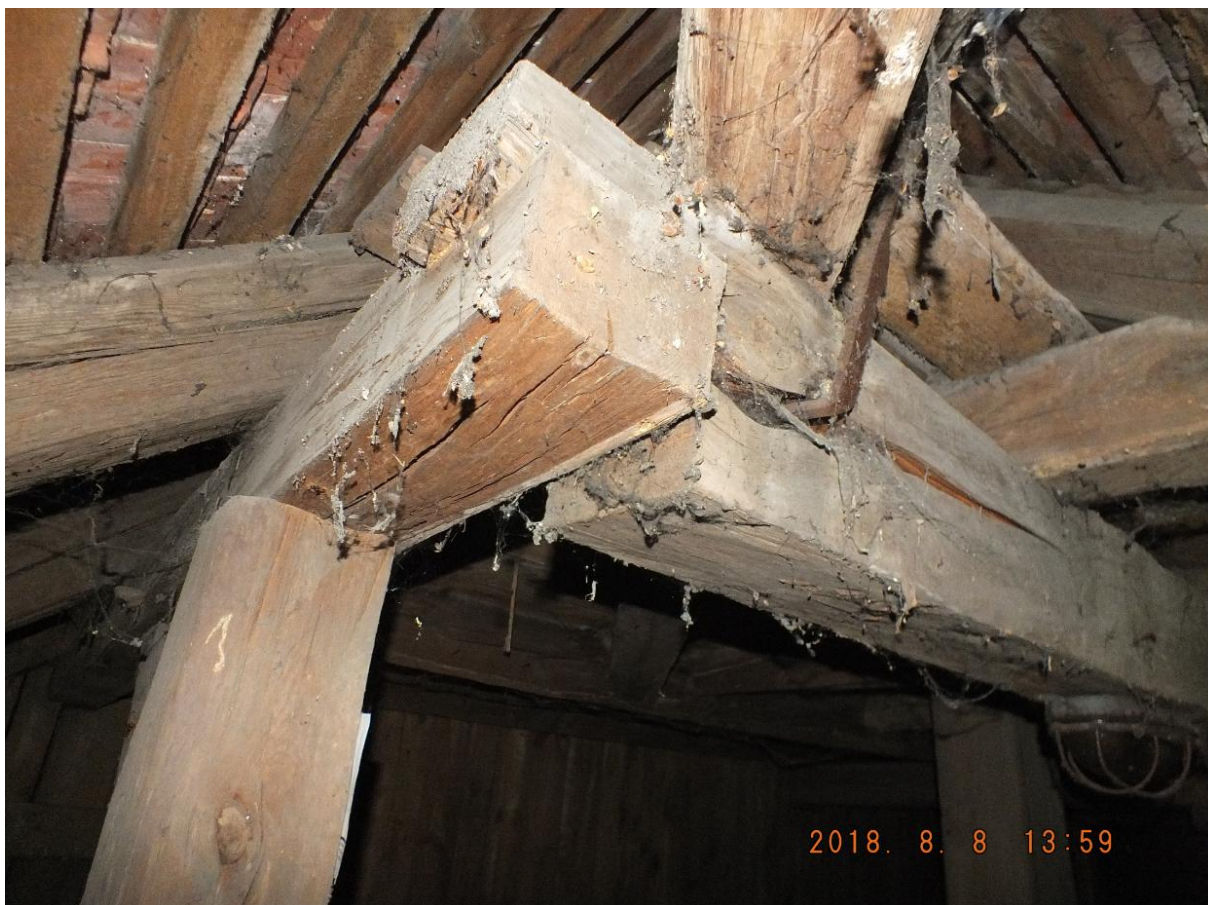
Fot. 20. Widok wtórnie wzmocnionego węzła wzmocnionego klamrami
