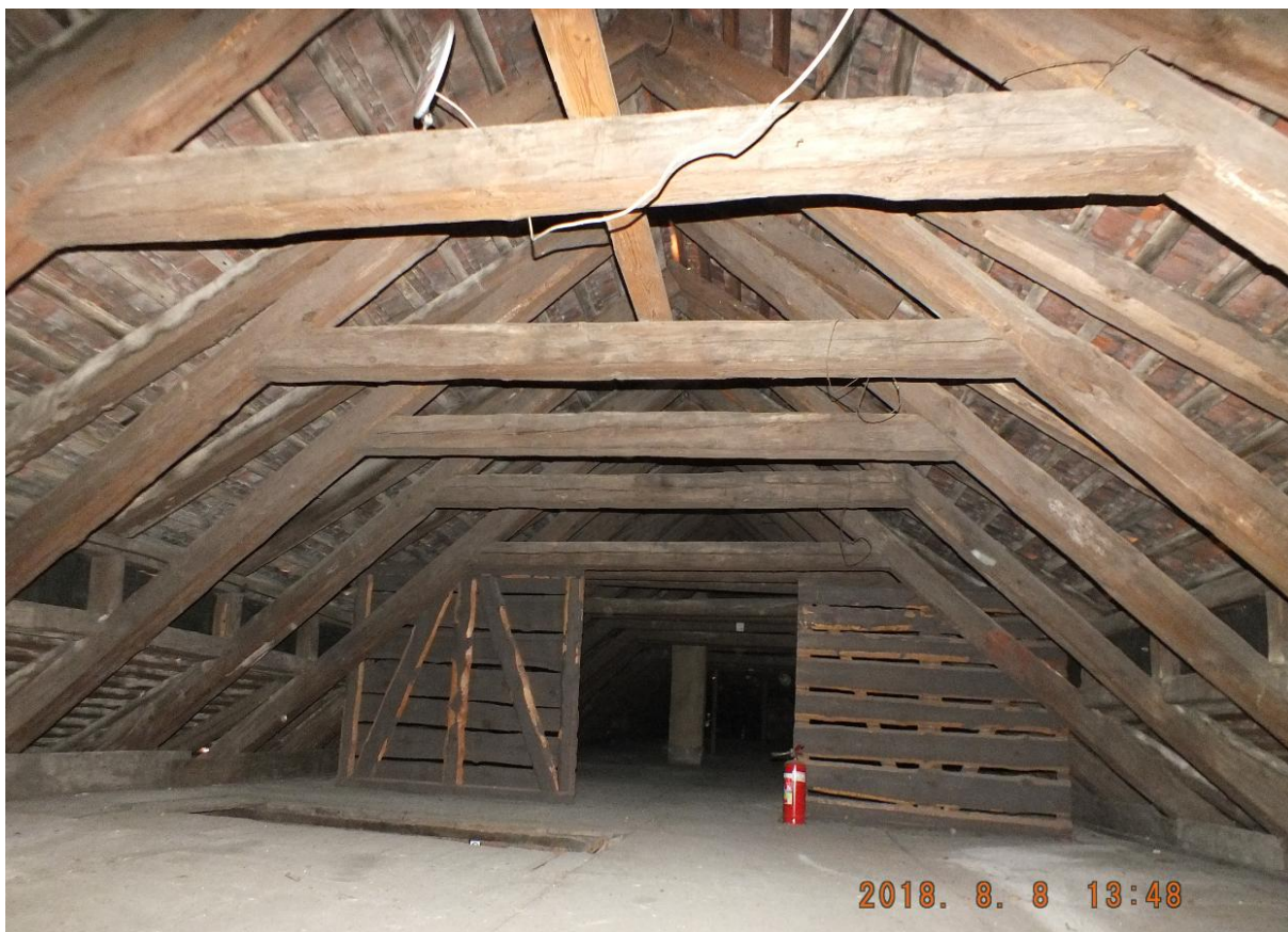
Fot. 12. Widok ogólny wyższego poziomu więźby dachowej
