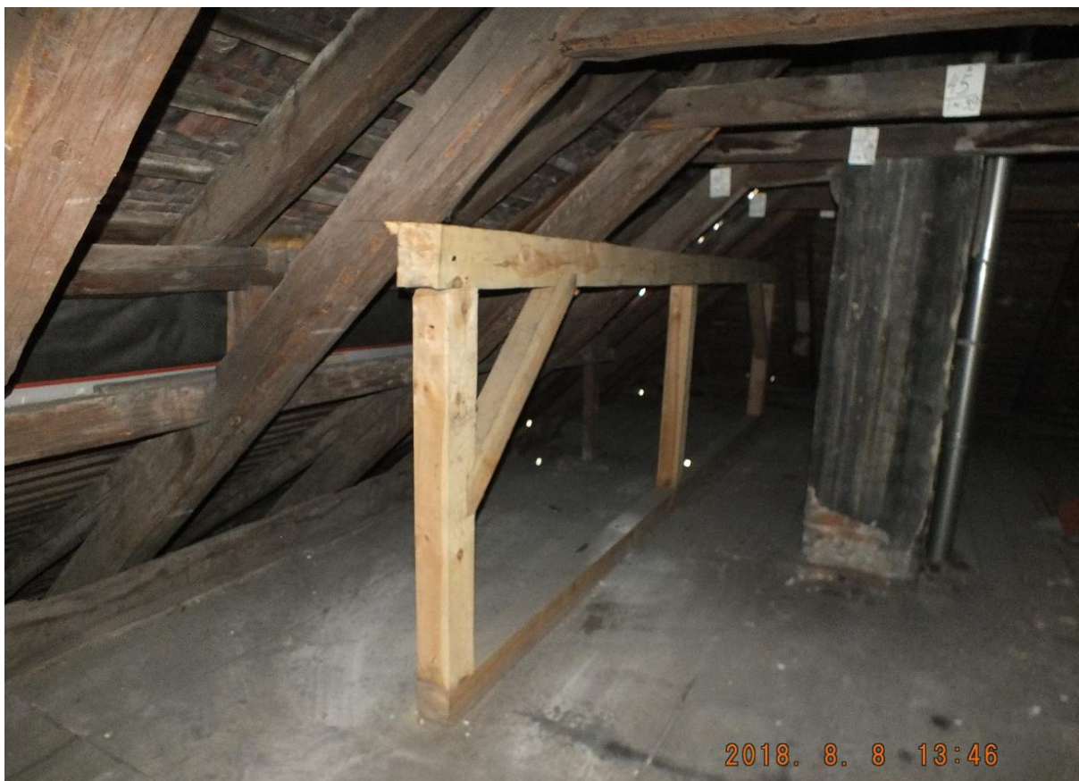
Fot. 23. Widok wtórnego wzmocnienia więźby w postaci drewnianych ram wsporczych
