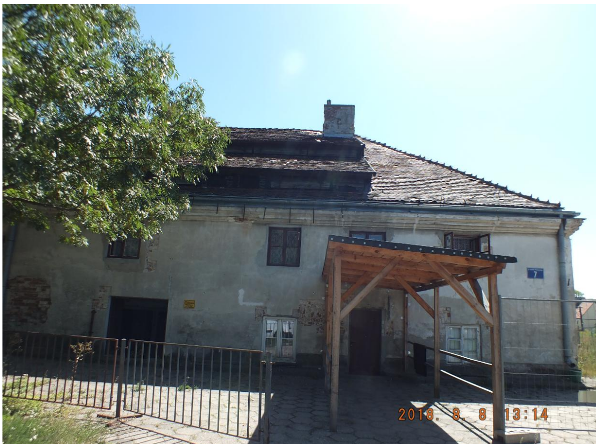
Fot. 8. Widok strefy wejściowej do części mieszkalnej opisywanego obiektu
