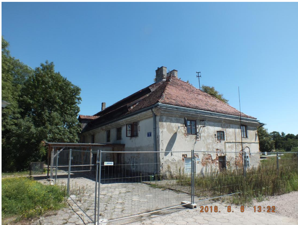
Fot. 2. Widok ogólny budynku słodowni wchodzącego w skład obiektów gospodarczych Palacu w Wilanowie
