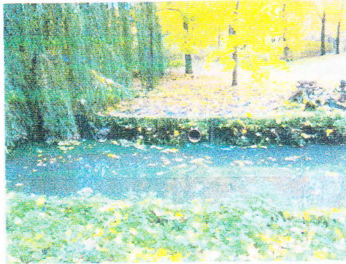
Nowy, wymienny wylot B' PVC \varnothing 315 mm do Potoku Służewieckiego (rzędna dna 6,60 m. n. „0” Wisły, 84,56 m. n.p.m. „0” Wisły w układzie „Kronsztad 60”)
