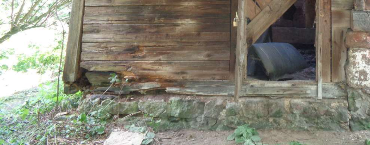
II. 3. Budynek Gajówki w Parku Morysińskim, ocena stanu zachowania fundamentu, widoczne ubytki w podmurówce oraz zielony nalot na powierzchni kamienia, ściana A, fot. A. Maślak, sierpień 2023
