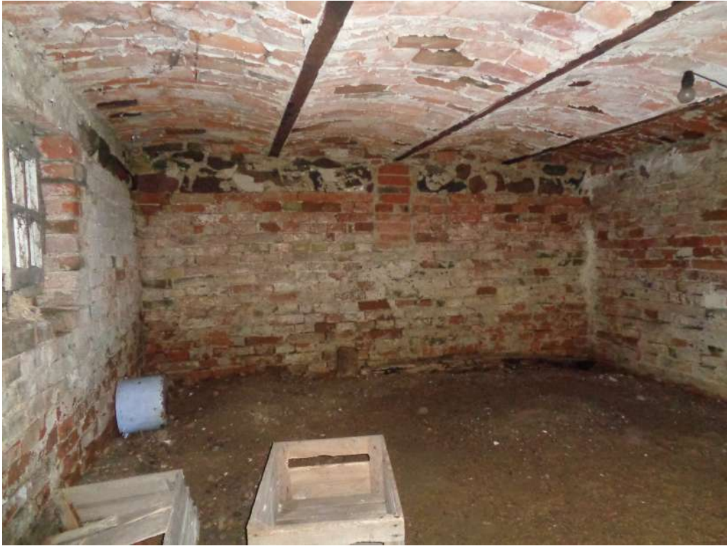
II.40. Budynek Gajówki w Parku Morysińskim, ocena stanu zachowania ścian piwnicy, widoczne zawilgocenie dolnej partii ścian, fot. A. Maślak, sierpień 2023
