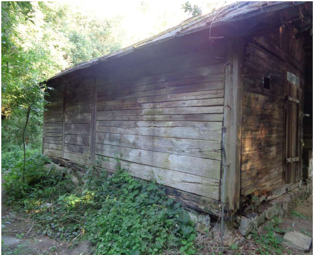
II. 3. Budynek Gajówki w Parku Morysińskim, ocena stanu zachowania fundamentu, widoczne ubytki w podmurówce oraz zielony nalot na powierzchni kamienia, ściana A, fot. A. Maślak, sierpień 2023
