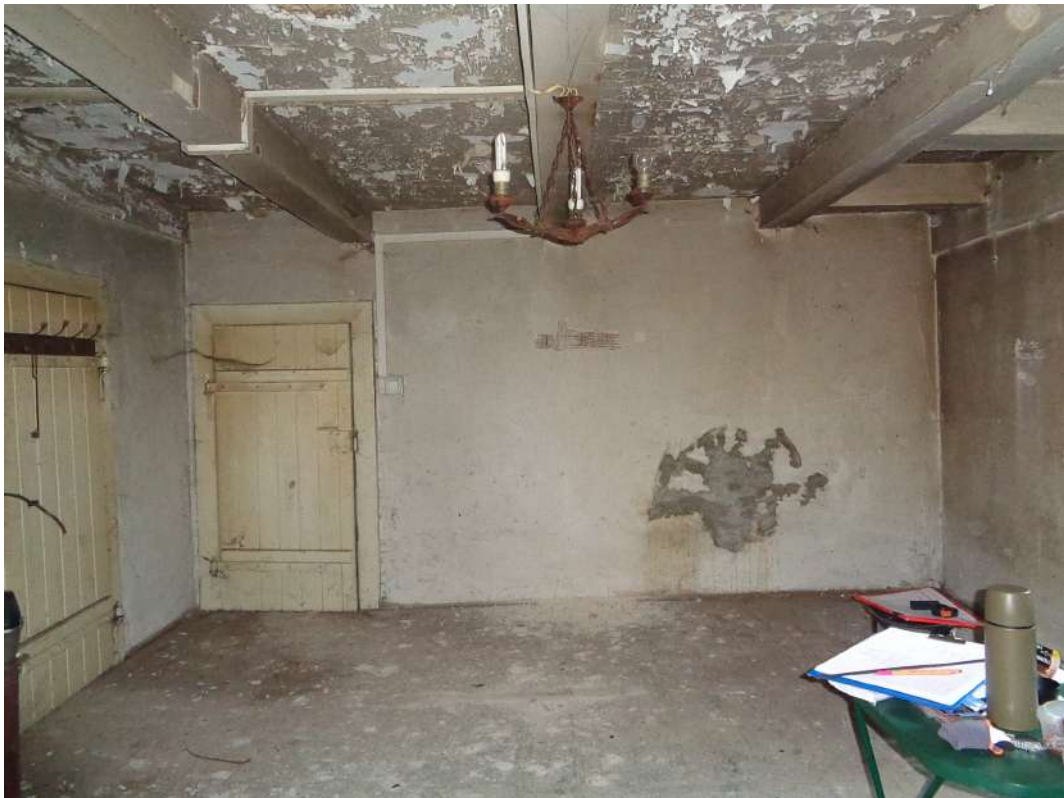
II.40. Budynek Gajówki w Parku Morysińskim, ocena stanu zachowania ścian piwnicy, widoczne zawilgocenie dolnej partii ścian, fot. A. Maślak, sierpień 2023
