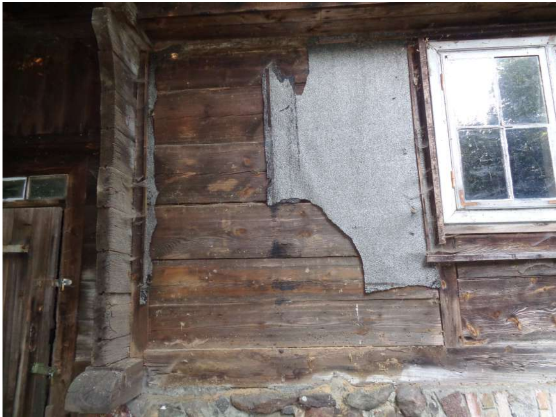
II.15. Budynek Gajówki w Parku Morysińskim, ocena stanu zachowania ścian obwodowych – ściana A, fragment ściany zasłonięty papą, fot. A. Maślak, sierpień 2023
